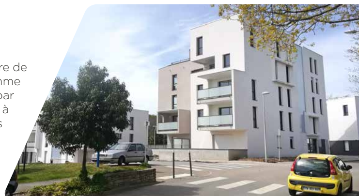
Les Marquises à Lorient : 27 appartements et 7 maisons en accession à la propriété • Livraison : mars 2019 Architecte : Daniel Le Dyllo
