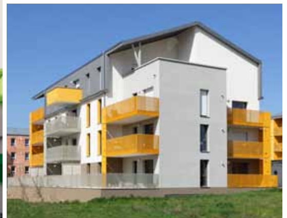
LE RHEU LES ARÔMES 18 appartements Architecte : Laurence Croslard
