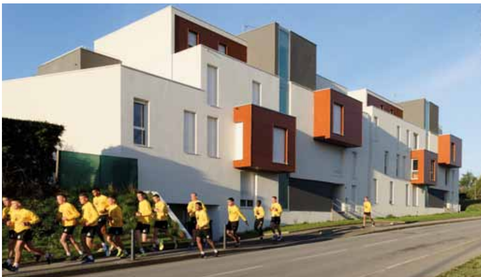
VANNES COULEUR ZEN 30 appartements Architecte : Cabinet Arcau
