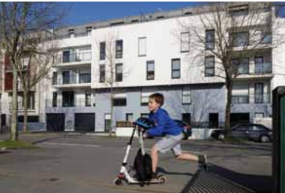
NANTES VILLA ONDA 36 appartements Architecte : Forest & Debarre
