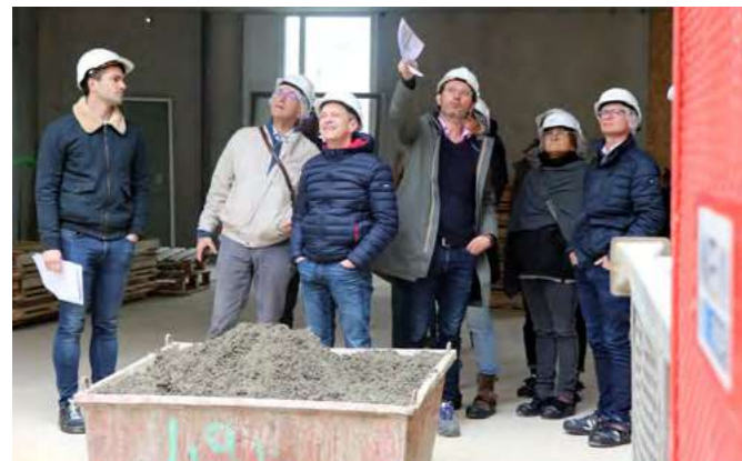
Visite de chantier du futur siège Odacité à Rennes par les collaborateurs.trices en attendant l'emménagement à l'automne 2024.
